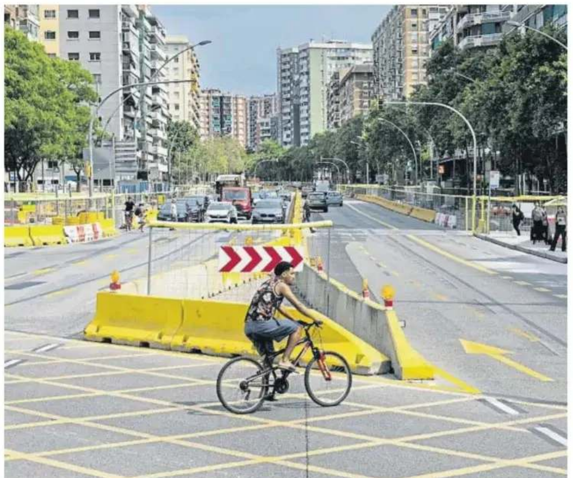
Obras en la Meridiana, otrora autopista urbana en vías de convertirse en una calle decente
